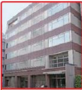
Kyosei Co., Ltd. HQ (Tokyo)
